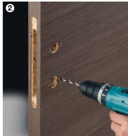
2 Führungsbohrungen für Stütznocken einbringen (für diesen Arbeitsschritt das Schloss entfernen)
