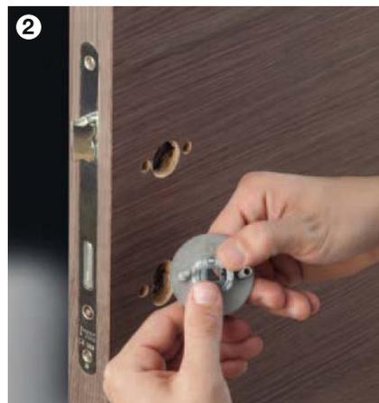
Rückholfeder auf der Rückseite der Griffrosette eingeklipst
