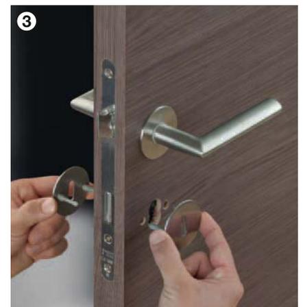
Bei Bedarf Schlüsselrosetten montieren – fertig!
